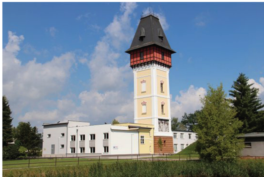
Vodáreňská věž , České Budějovice
